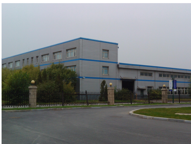
图 5 项目厂区西侧
