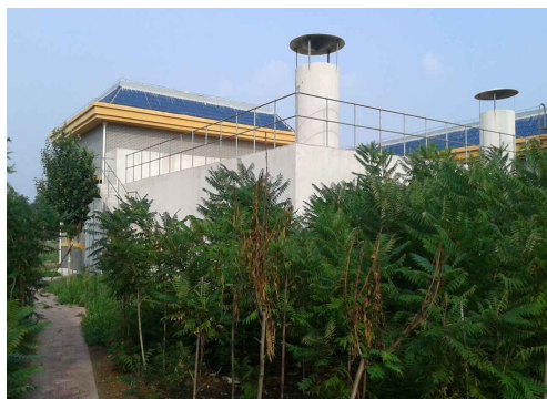
图 3-3 封闭预处理区恶臭排放口
