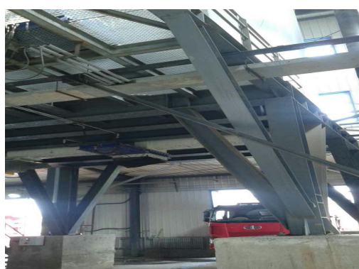
图 3-8 污泥间内专用运输车正在装车
