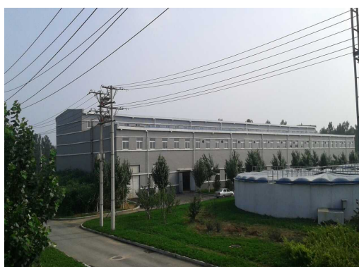
图 3-2 已封闭污泥处理区
