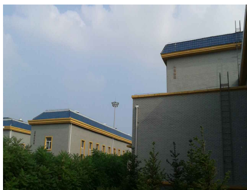
图 3-1 已封闭预处理区
