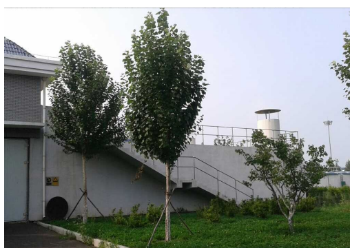
图 3-4 封闭污泥处理区恶臭排放口
