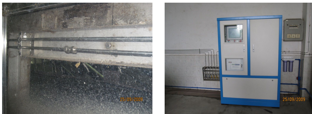
图 8-3 广州市猎德污水处理厂（120 万吨/天）一、二、三、四期格栅机及提升泵房、曝气沉砂池、脱水机房喷雾除臭工程现场照片
