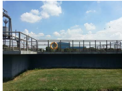
图 12 现状加氯消毒池
