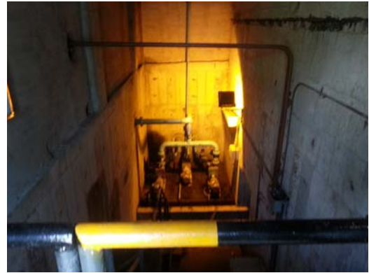
图 4 现状提砂泵房
