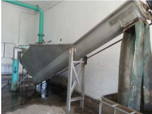
图 5 现状分砂机房
