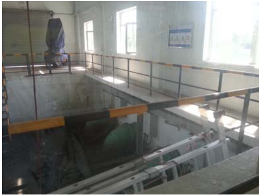
图 3 现状污水提升泵房
