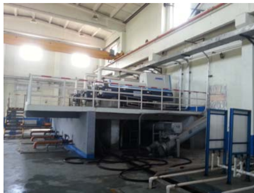
图 7 现状污泥脱水间
