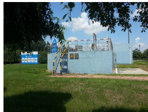
图 14 现状回流污泥和剩余污泥分流泵房
