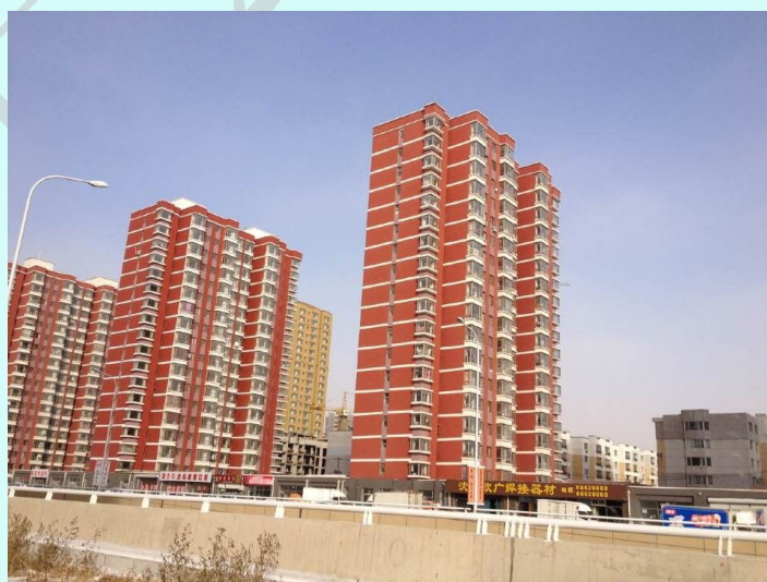
图 1.7-2 长青下穿桥匝道东北侧天泰翰宇苑
